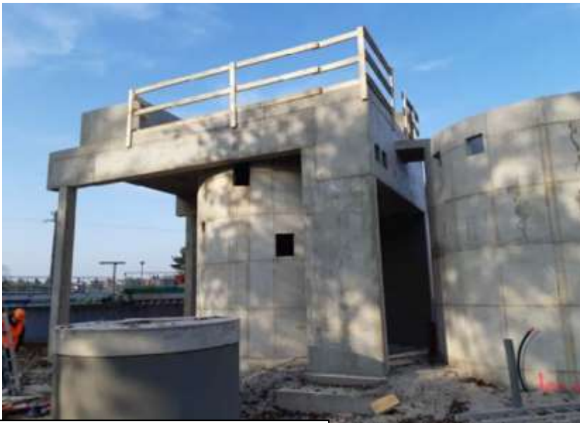
Ouvrages de pré-traitement
